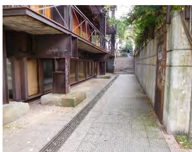
Rejilla con huecos excesivos en espacios de circulación
