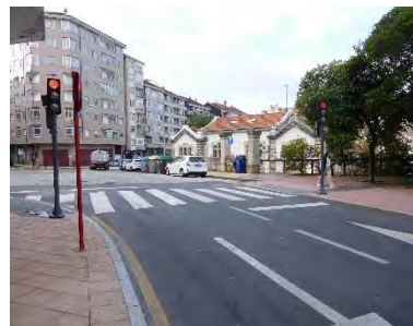
Vados peatonales de tres pendientes
