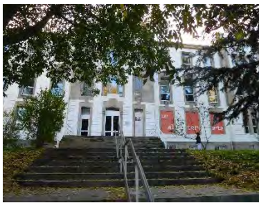
Mesetas de Escalera E8 sin pasamanos
