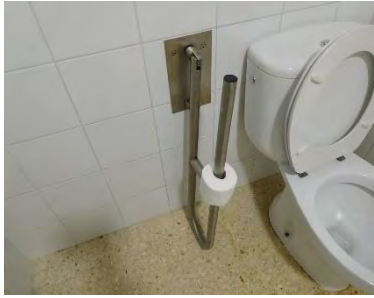
Barras de apoyo abatibles rotas
