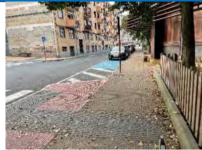
Plaza reservada para PMR
