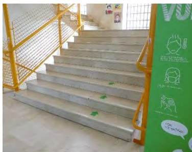
Embarques sin pavimento podo táctil
