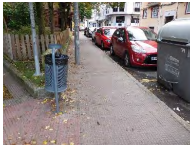
Papelera de altura adecuada y contenedor con boca a altura excesiva
