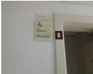
Cabinas sin señalización SIA adecuada
