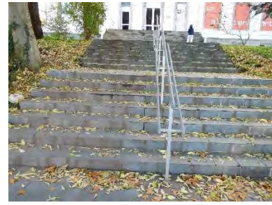
Escalera E8 con pasamanos inferior
