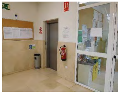
Acceso principal de Edificio 2 sin punto de atención ni llamada accesible
