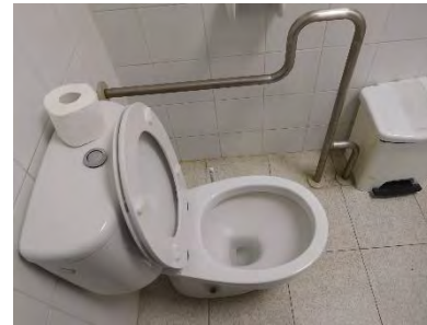
Barras de apoyo no horizontales
