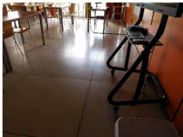
Elementos volados en Aulas
