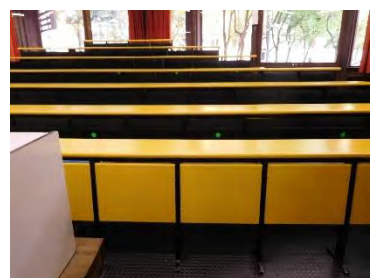
Inexistencia de plaza adaptada para PMR en mobiliario fijo
