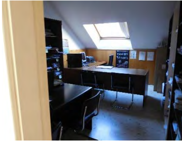
Espacios insuficientes en despachos y baja altura; Edif 1
