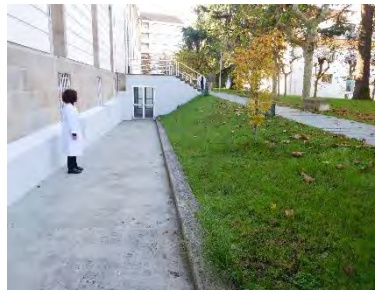
Zonas en talud sin protección de desniveles
