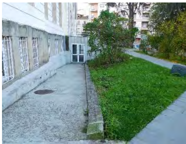
R4, pendiente y longitud de tramo excesivas.
