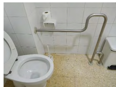
Barras de apoyo no horizontales
