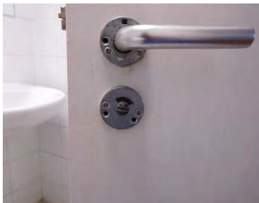
Cancelas que permiten el desbloqueo y marcan estado de ocupación
