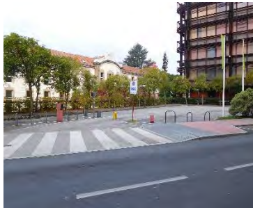
Vados peatonales rebajados de una pendiente
