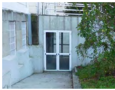
Puertas de vidrio sin señalización, accesos sin señalización visual ni alternativa, Acceso 2
