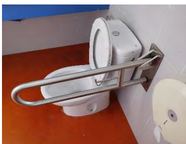
Barras de apoyo en un solo lado
