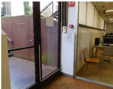
Puertas con barras antipánico, Edif. Ferro
