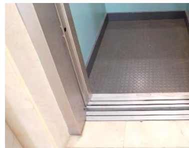
Sensor anti aprisionamiento, localizado en un único punto
