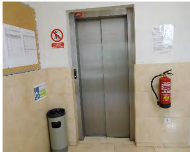
Puerta de dimensiones inferiores a las admisibles
