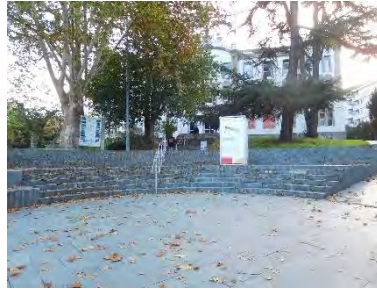
Pavimento deslizante de pizarra en E8
