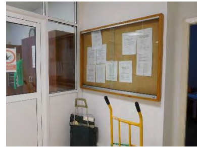
Señalización no adecuada en vestíbulos
