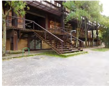
Espacio bajo escalera zona oeste
