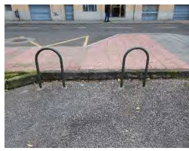
Bolardos con diseño inadecuado
