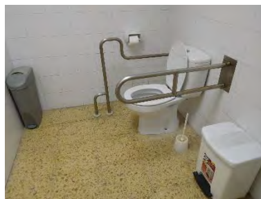
Cabinas adaptadas tipo C1 masculina, sin \geq 1,50 m
